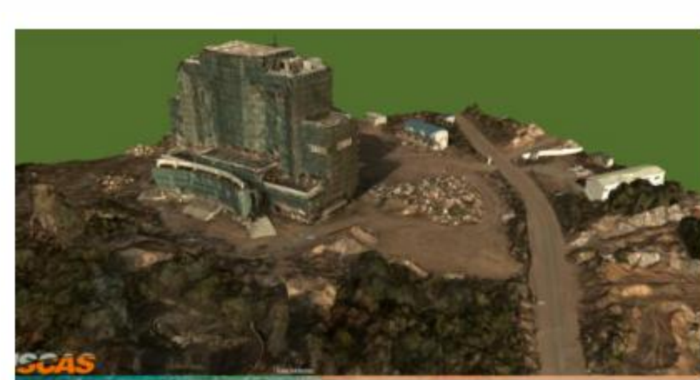
倾斜影像构建三维建筑
